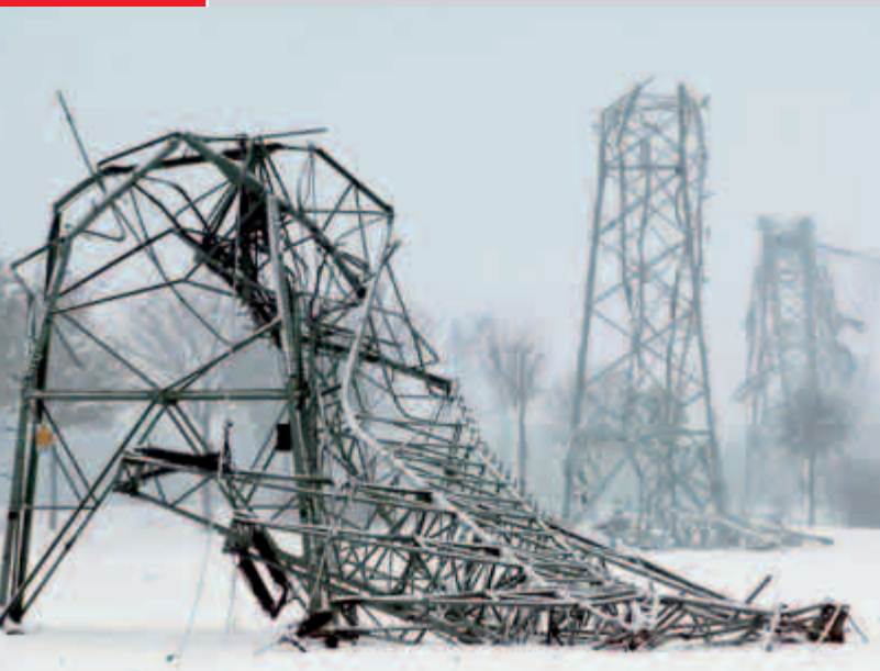
Schnee und Eis ließen Ende November über 80 Strommasten im Münsterland – wie hier auf einem Feld bei Laer – umknicken (Quelle: dpa).
