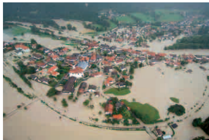
Die überflutete Ortschaft Eschenlohe während des Auguthochwassers 2005 (Quelle: dpa).
