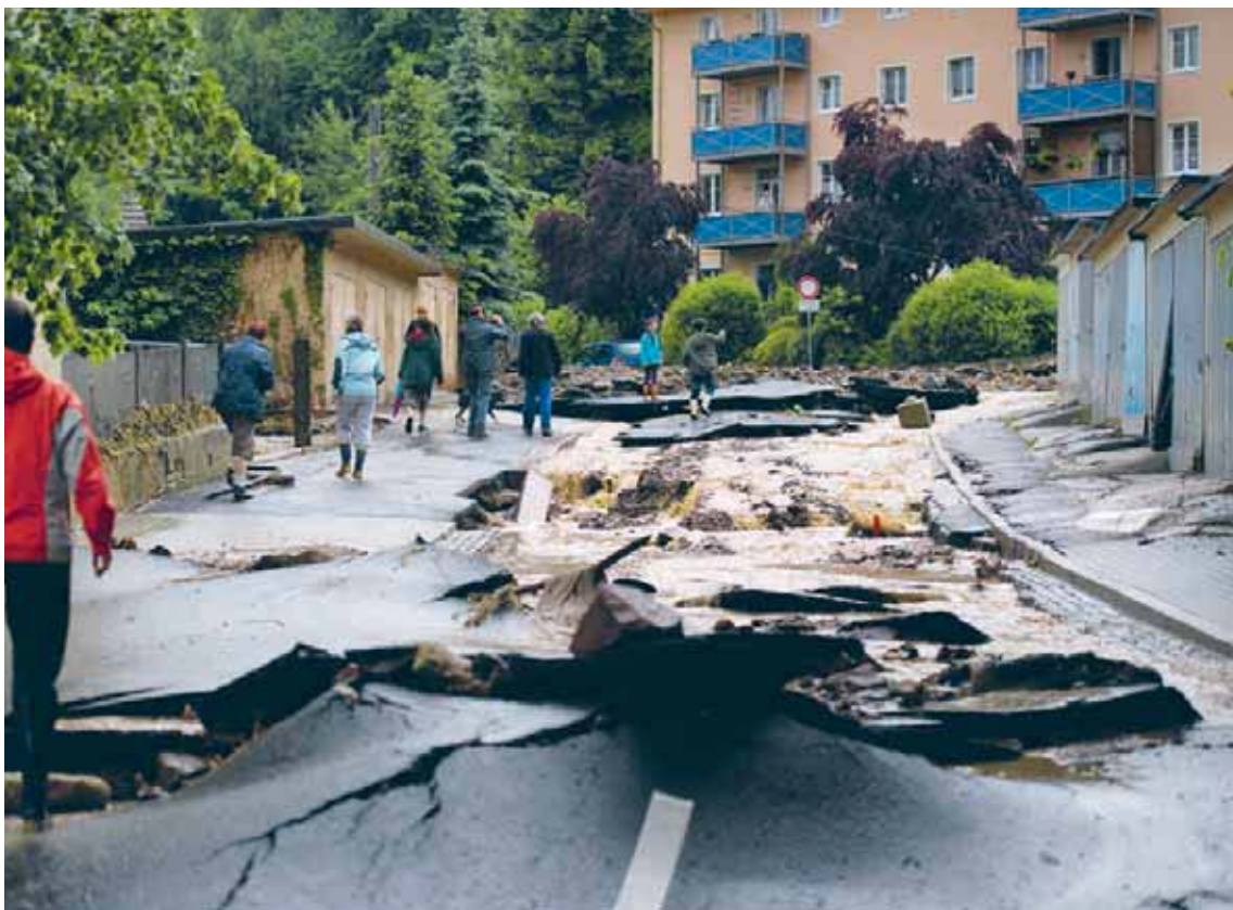
Einen buchstäblich großen Aufriss machte eine Schlammlawine am 27. Mai auf dieser Straße in Meißen (Sachsen). Zum Ende des Wonnemonats fielen in weiten Teilen der Republik große Mengen an Niederschlag. (Quelle: picture alliance/dpa, Arno Burgi)
