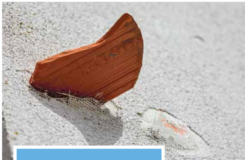
Welche Kräfte bei einem Tornado mitunter wirken, zeigt eindrucksvoll dieses Bild: Eine Dachziegelscherbe kann aufgrund der extrem hohen Windgeschwindigkeiten regelrecht zum Wurfgeschoss werden und sich selbst in Hausfassaden tief hineinbohren.
