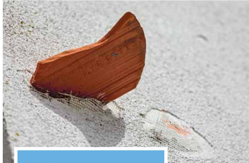
Welche Kräfte bei einem Tornado mitunter wirken, zeigt eindrucksvoll dieses Bild: Eine Dachziegelscherbe kann aufgrund der extrem hohen Windgeschwindigkeiten regelrecht zum Wurfgeschoss werden und sich selbst in Hausfassaden tief hineinbohren.
