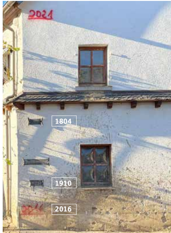
Die auf diesem Wohnhaus in Dernau im Ahrtal aufgetragenen Pegelstände historischer Überschwemmungen führen das komplette Ausmaß des Hochwassers im Juli nochmals eindrücklich vor Augen. Lokale Aufstauereffekte hatten hier zu extremen Wasserständen geführt. (Quelle: Artur Kubik)
